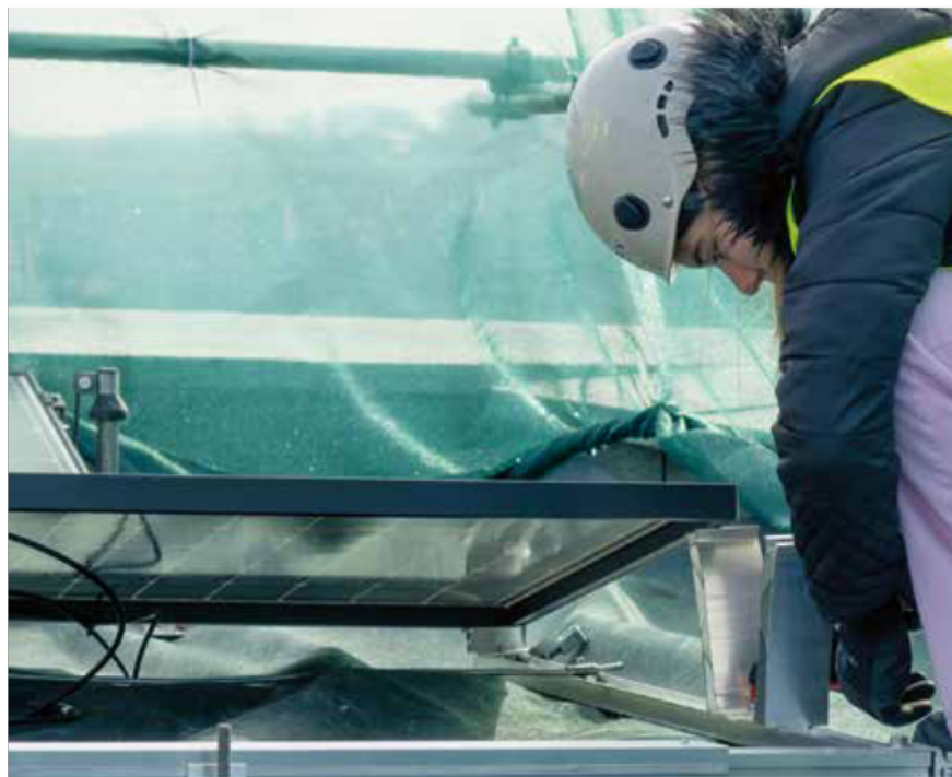
L'installation de panneaux photovoltaïques n'a plus de secret pour ces élèves. © Ville de Fribourg/Hoang Anh Nguyen
